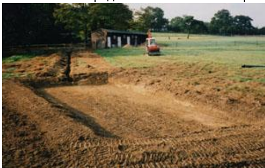
Слика 5.9: Изградба на типична леа со трска
