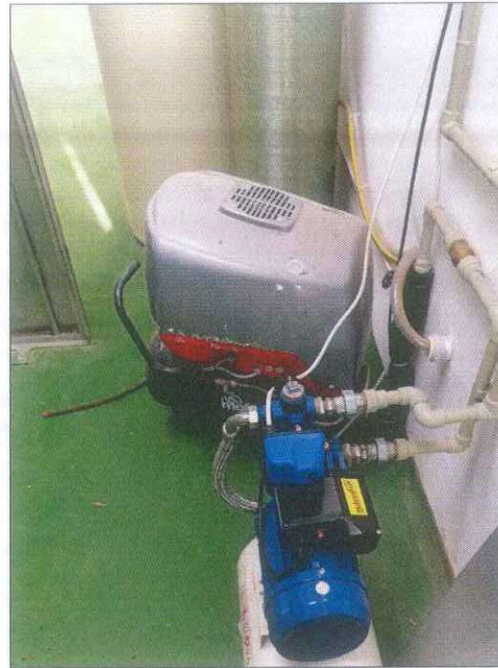
Слика 34: Монтиран хидрофор
