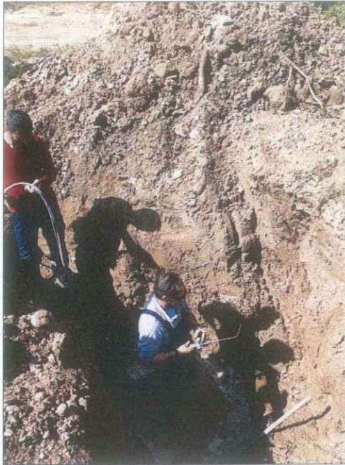
Слика 33: Санација на водоводна мрежа
