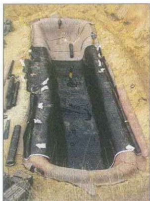
Слика 9: Изградба на депонија за азбест
