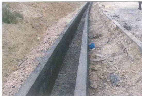
Слика 15: Бетонски ободни канали
