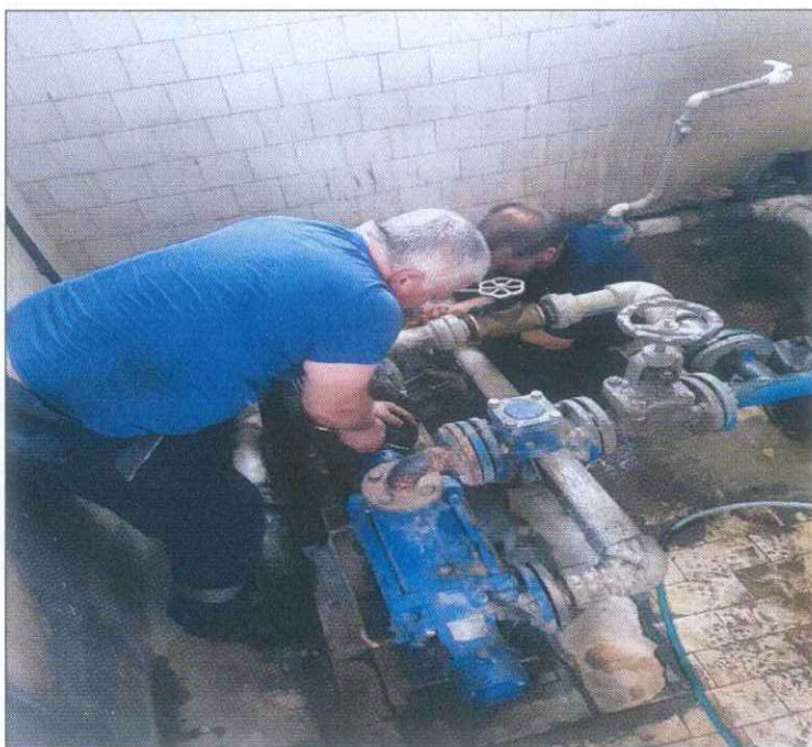
Слика 32: Сервисирање на центрифугална пумпа
