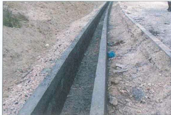
Слика 14: Бетонски ободни канали
