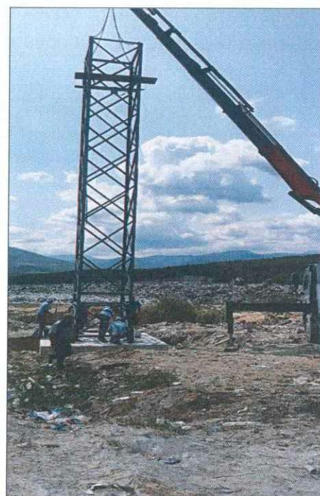
Слика 35: Поставување на решеткаст столб
