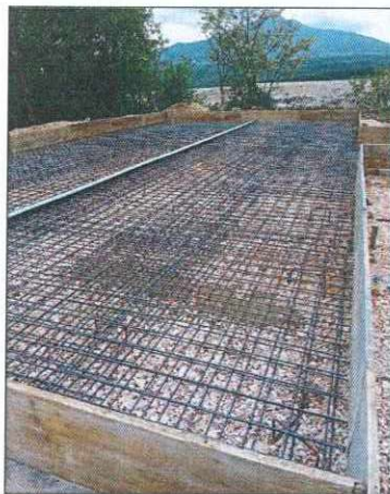
Слика 20: Изведба на бетонско плато за перење и подмачкување на градежни машини
