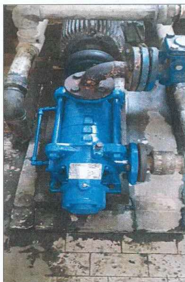
Слика 31: Монтирана нова центрифугална пумпа
