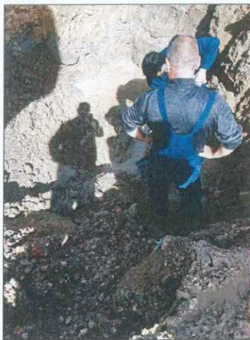
Слика 30: Остранување на дефект на главната водоводна мрежа
