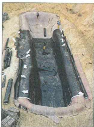
Слика 9: Изградба на депонија за азбест
