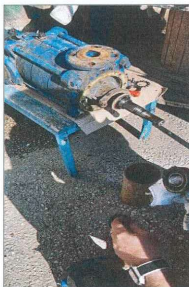
Слика 32: Сервисирање на прва центрифугална пумпа
