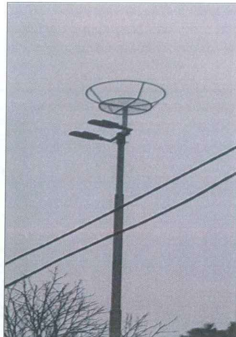
Слика 34: Поставување на седла за штркови
