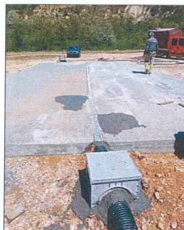
Слика 20: Изведба на бетонско плато за перење и подмачкување на градежни машини
